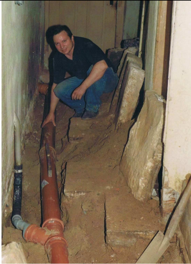
Abbildung 6 Stolpen – Vorwerk 12, (Juni/Juli 1991), Hausflur, Verlegung von Abwasserkanälen, Fundschichten Keramik; auf dem Foto Herr Uwe Rosendahl
